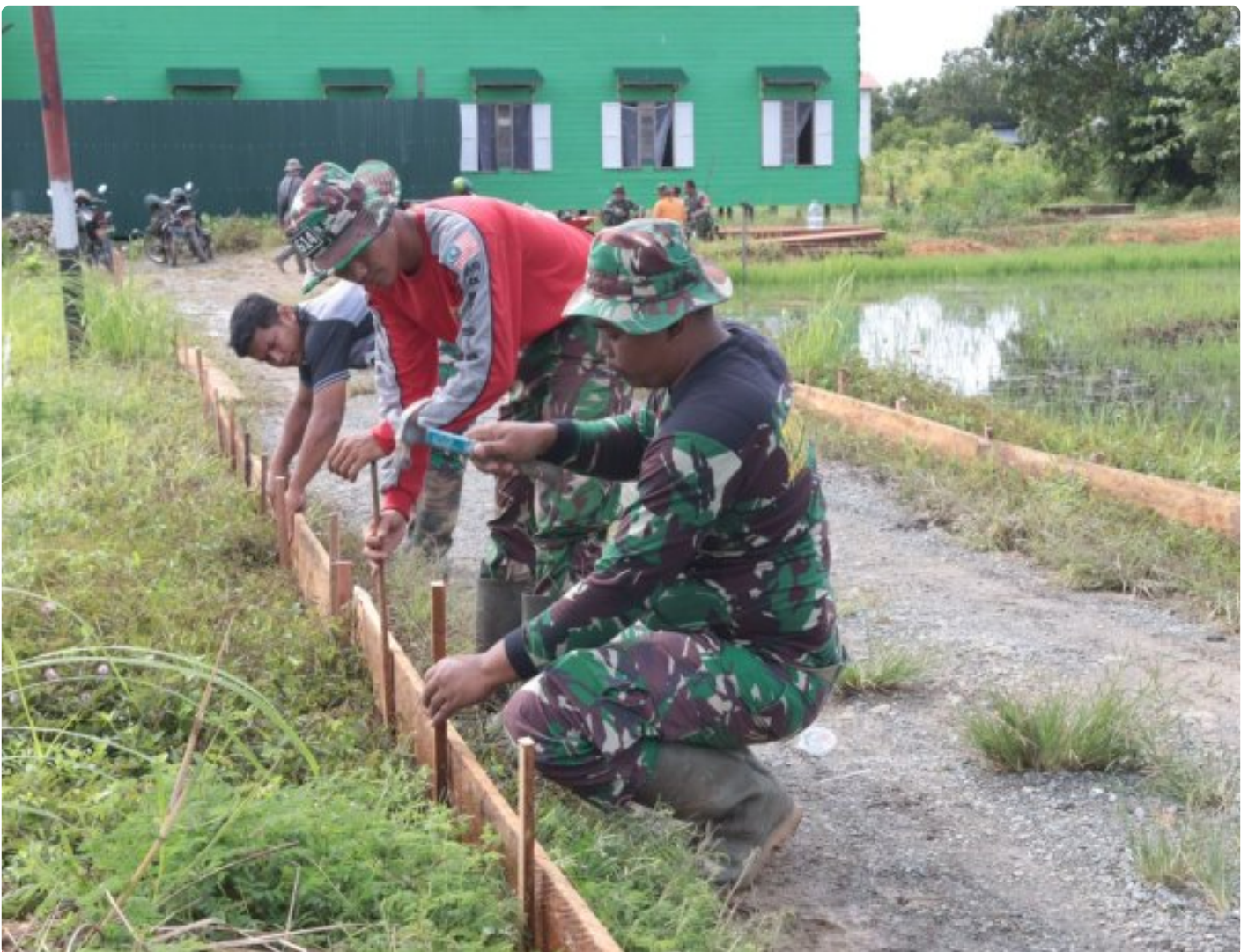
TMMMD ke- 118 Kodim 0910/Malinau Bantu Percepat Pembangunan Daerah
