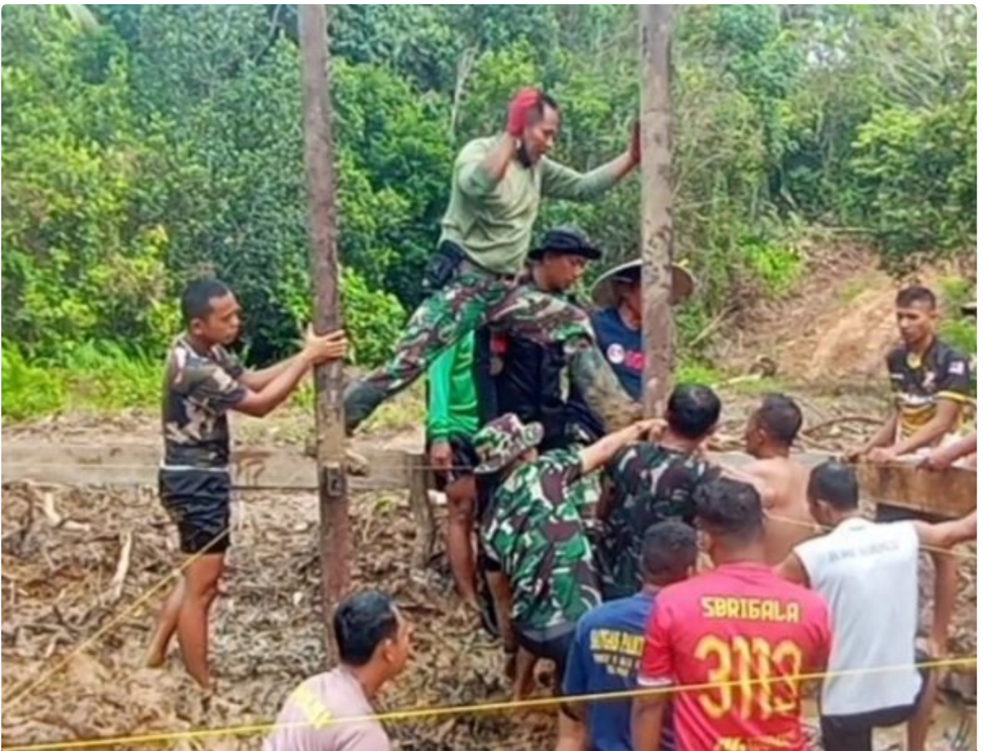
Satgas TMMD ke- 118 Wiltas Kodim 0910/Malinau Pasang Tiang Pancang Jembatan
