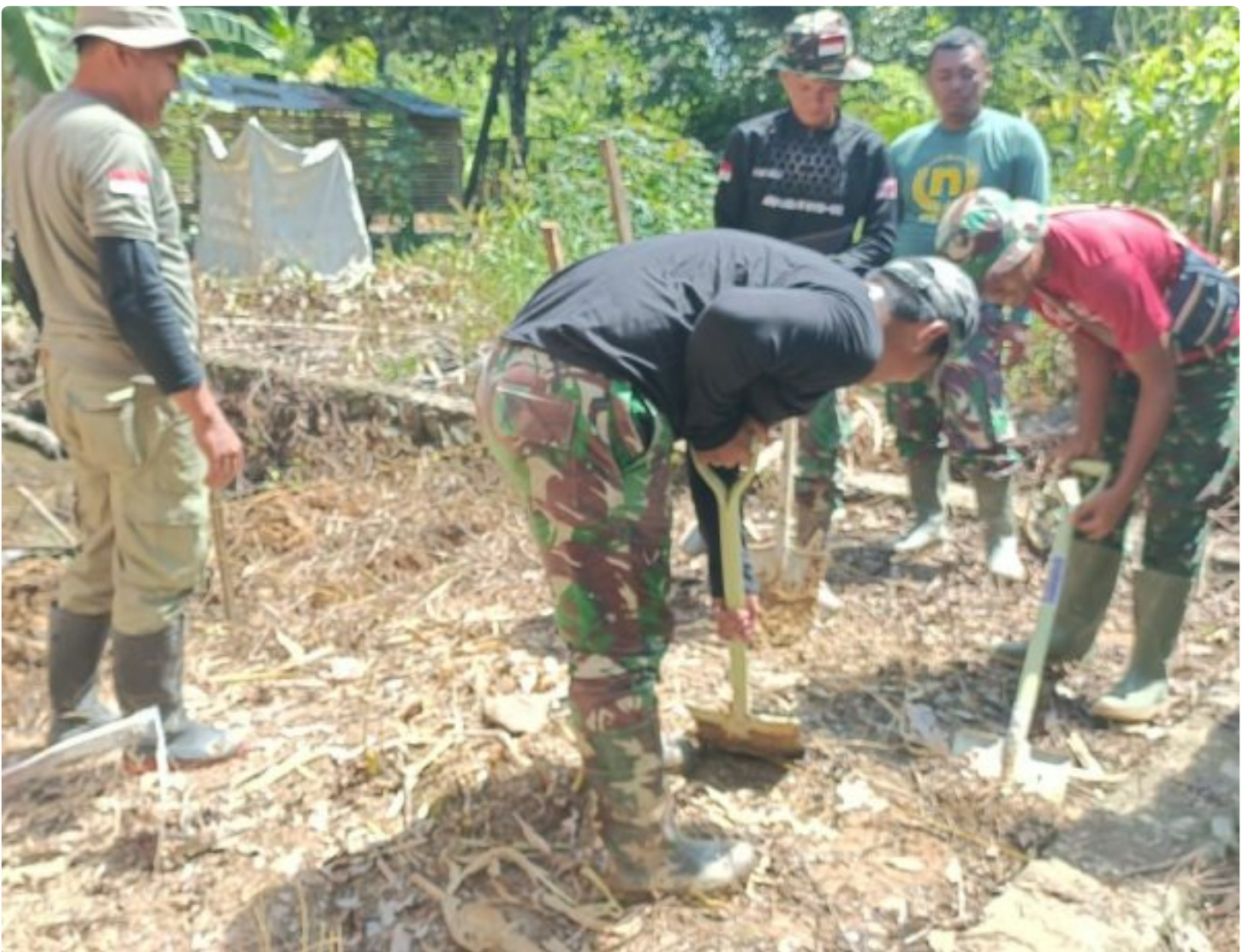
Sasaran Tambahan TMMD Ke-118 Wiltas Kodim 0910/Malinau Mulai di Kerjakan
